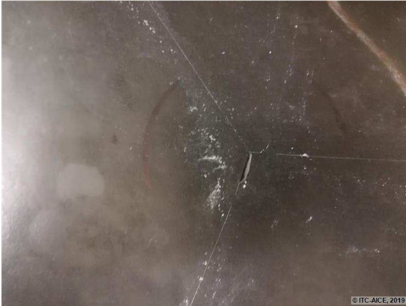
Figura 142. Detalle de los defectos de la probeta R5 - 14
