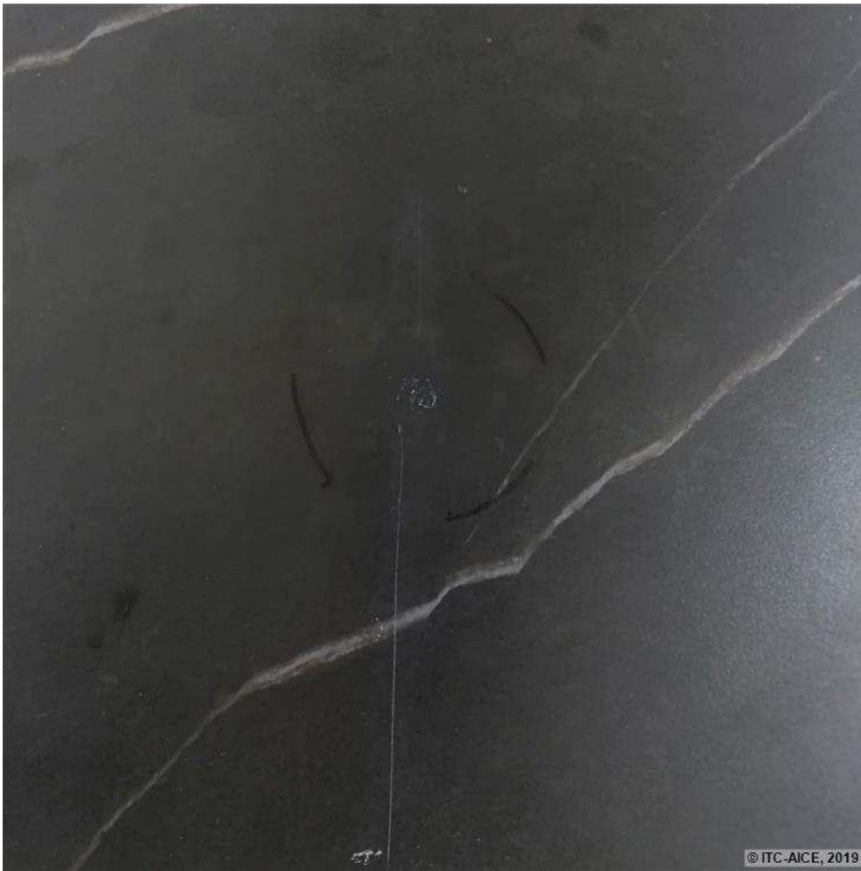
Figura 116. Defectos aparecidos en la probeta ON1-11. Se puede observar la fisura radial que atraviesa la pieza desde el centro hasta el extremo de la probeta
