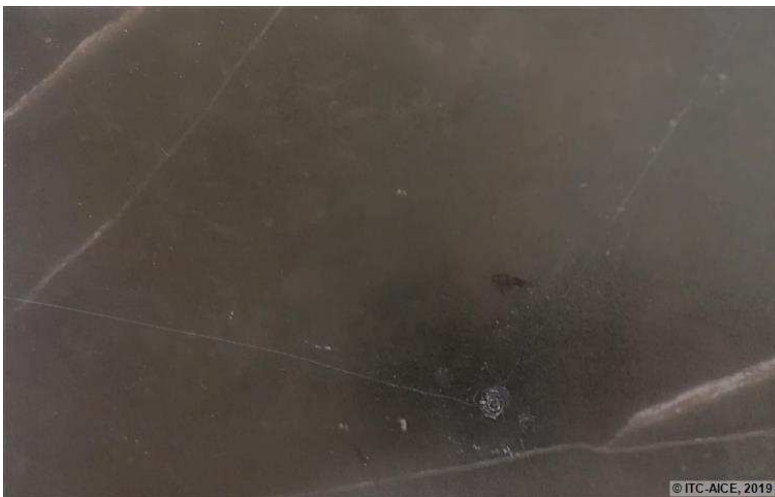
Figura 130. Detalle de las fisuras radiales de la probeta ON4-11
